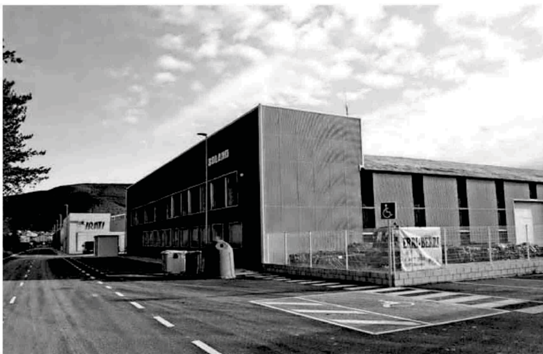
Parte de las antiguas naves de Solano se están reconvirtiendo en un centro logístico de biomasa.
