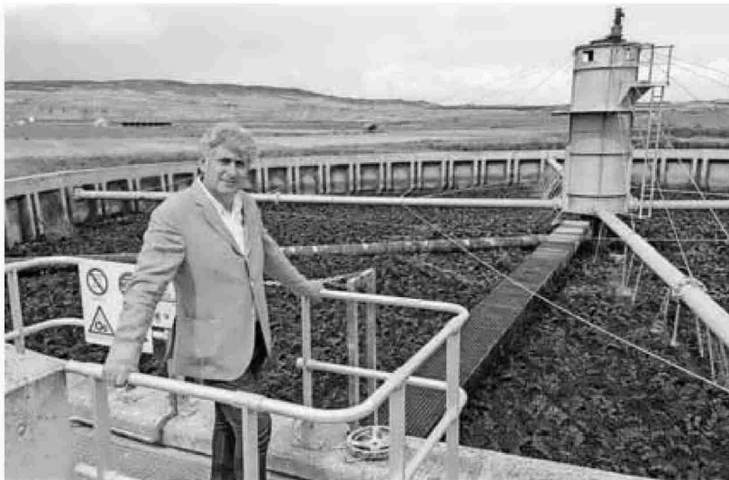
Fernando Mendoza, director gerente de Nilsa, en la depuradora de Valtierra-Arguedas, donde también se instalarán paneles solares.
