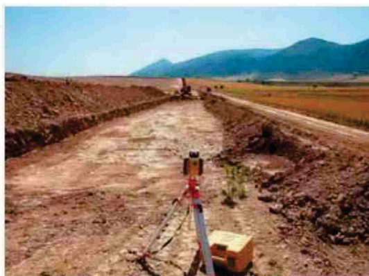
Obras de urbanización en terrenos donde irá la planta.
