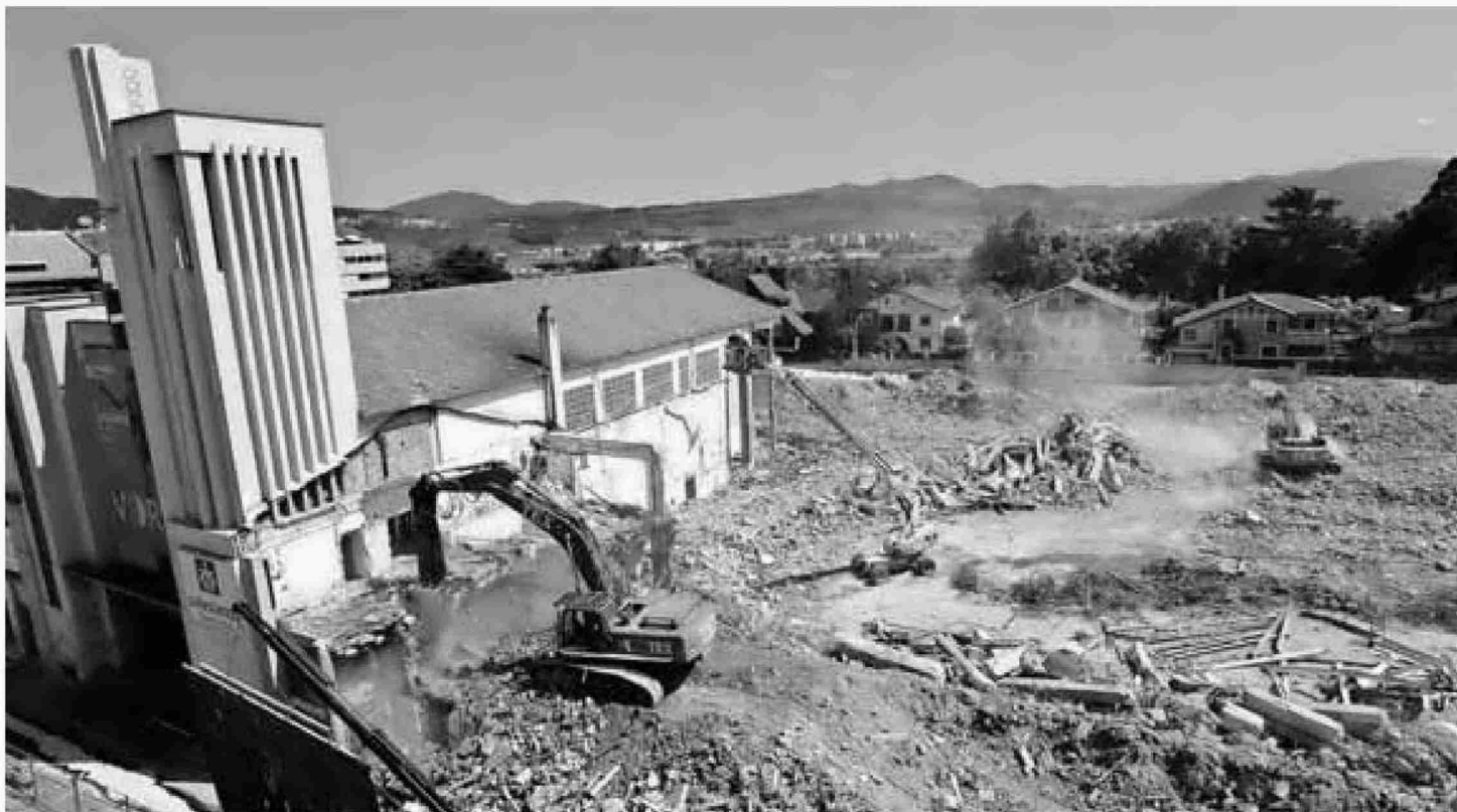
La pala excavadora arremete contra la torre principal del antiguo colegio situado en el Ensanche.
