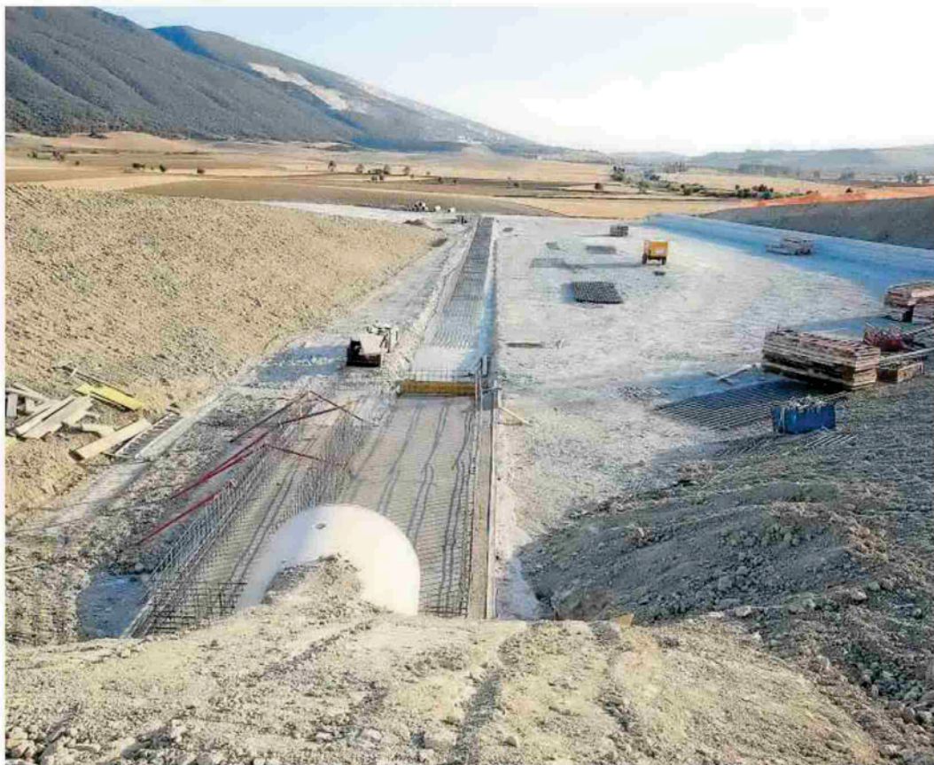
Imagen de los trabajos de urbanización que se están llevando a cabo en la parcela del futuro centro de Imárcoain.
