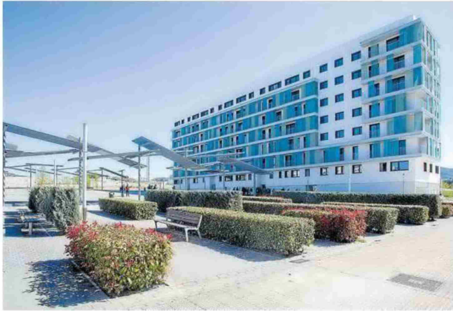
Exterior de las viviendas VPO finalizadas por Nasuvinsa en Erripagaína. Foto: Patxi Cascante
