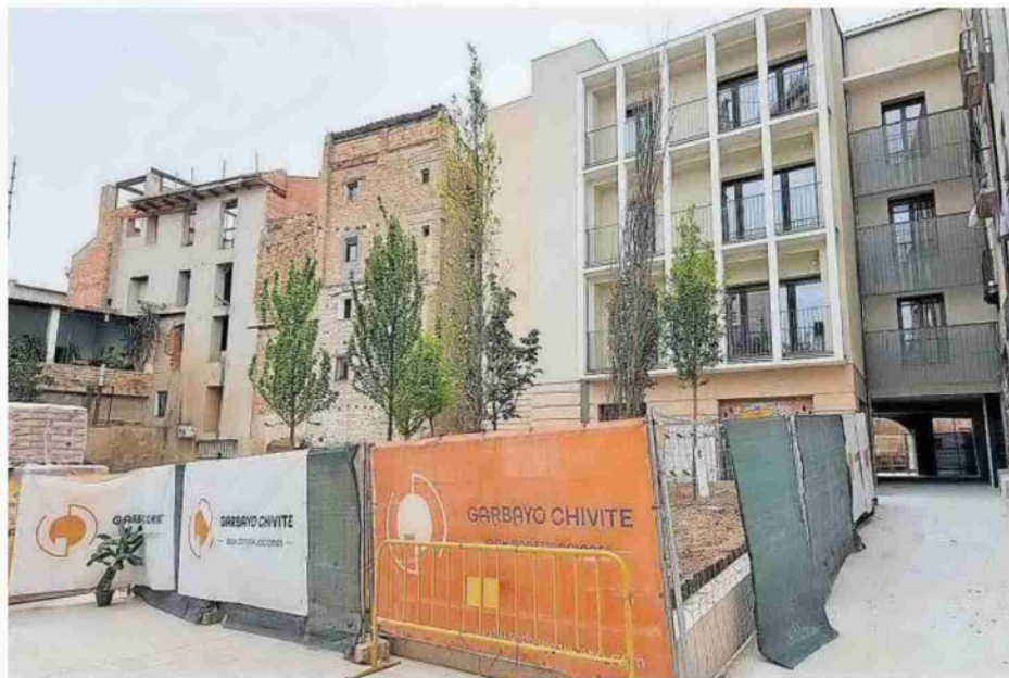
Vista general de la plaza de Coscolín, desde la entrada por San Antón, y el edificio cuya fachada da a la plaza Vieja.
