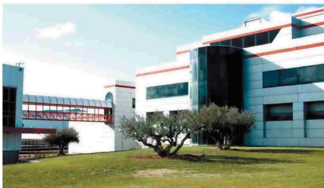
Exterior de las instalaciones de Dynamobel en Peralta.
