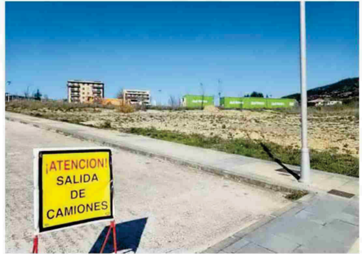
Término de Ibarra donde se están construyendo las nuevas viviendas. Foto: Javier Arizleta
