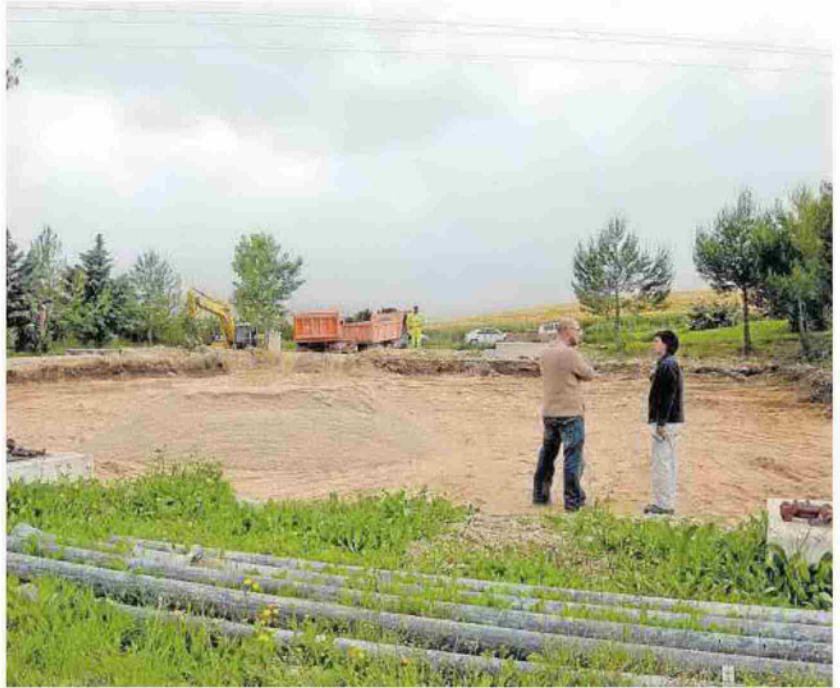
Obras de proyección del filtro de arena en la depuradora de Lerate, en 2007. Foto: D.N.
