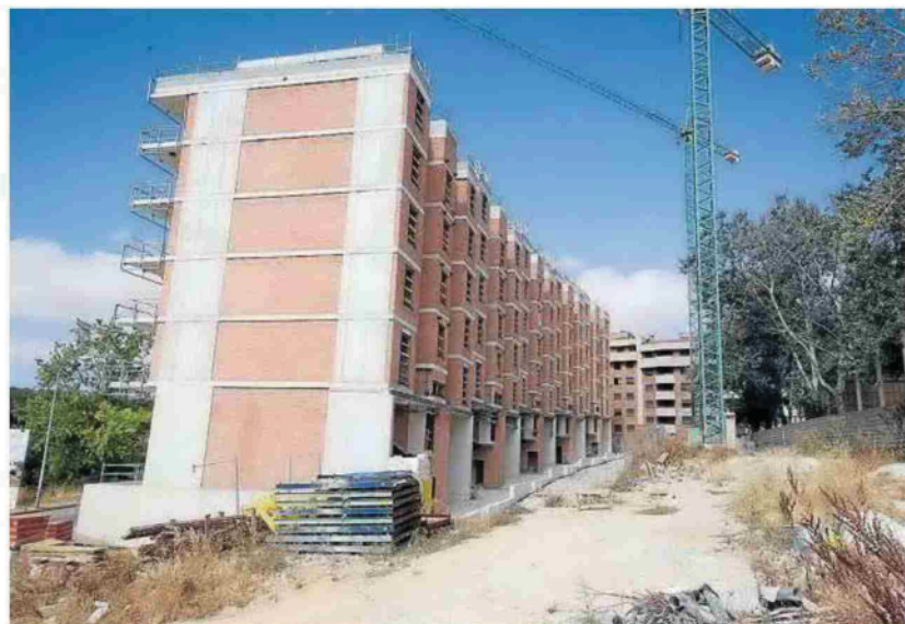
Obras paradas en las viviendas de VPO en Barañáin.
