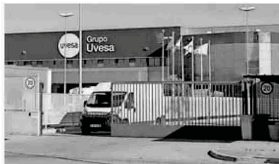
Factoría de Uvesa ubicada en el Polígono Montes de Cierzo de Tudela. DN
