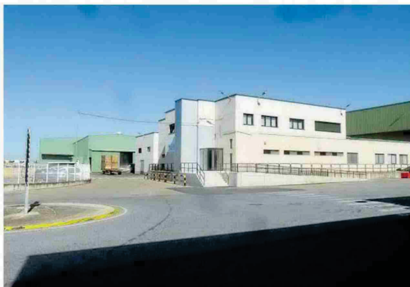
Instalaciones de la empresa Gelagri, situadas en Milagro. Fotos: Diario de Noticias
