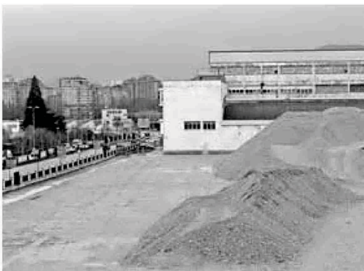
Vista del terreno que quedó tras demoler Superser.
