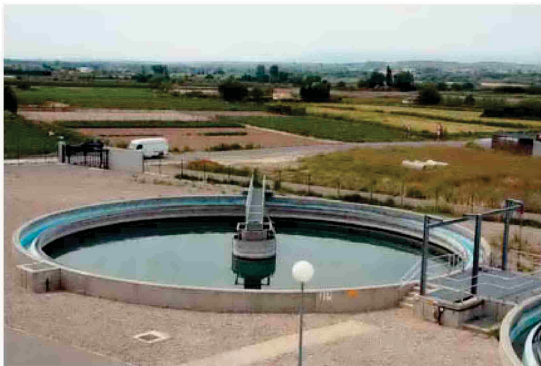
Depuradora de aguas residuales de Tudela. Al fondo, Fontellas.
