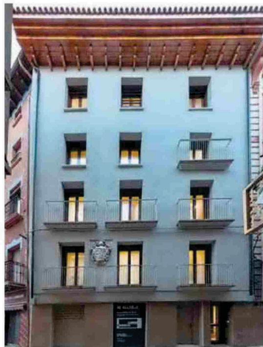
EN LA CALLE RÚA Imagen de la fachada del edificio reformado en la calle Rúa, número 3, ganador del Premio Ciudad de Tudela de Rehabilitación. CEDIDA
