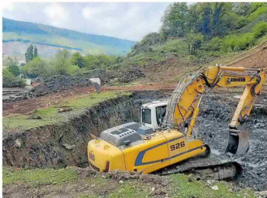
Las máquinas preparan el terreno para la nueva estación depuradora. Foto: Nilsa
