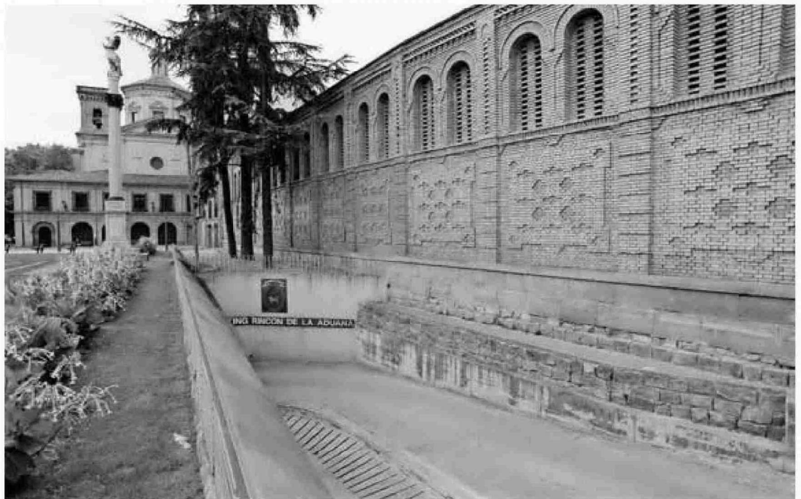
Edificio de las Salesas, en la calle Taconera, que en pocas semanas comenzará a rehabilitar la Mancomunidad.
