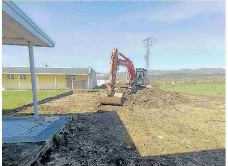
Operarios y máquinas han comenzado con los trabajos de cimentación. Foto: cedida
