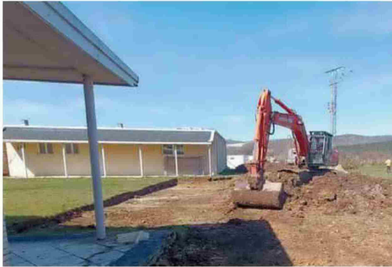
Detalle de las obras iniciadas en una parcela anexa al actual centro psicogerátrico.
