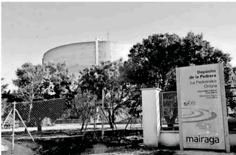
Planta potabilizadora de La Pedrera, ubicada en Tafalla.
