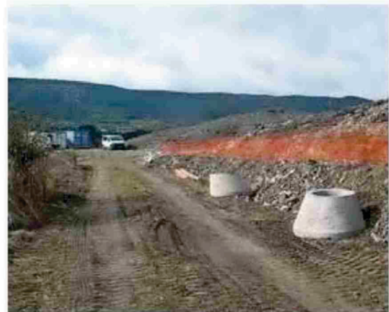
Primeros trabajos para la construcción de una depuradora en Meoz. DN
