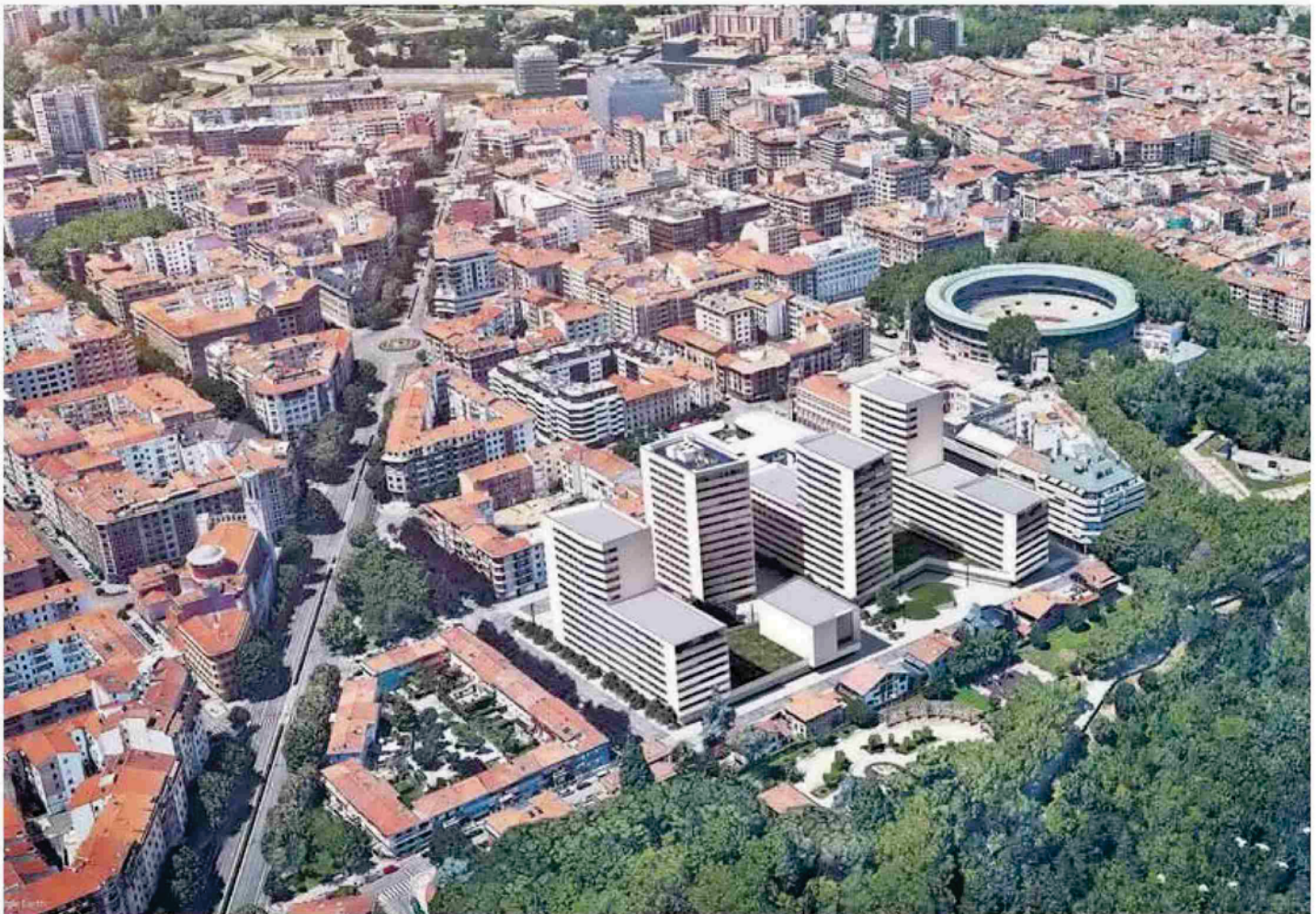
La nueva zona residencial de Salesianos, en una recreación, sobresale entre el resto de los edificios del II Ensanche. Abajo, a la derecha, las instalaciones del Club Natación, en el centro la plaza d
