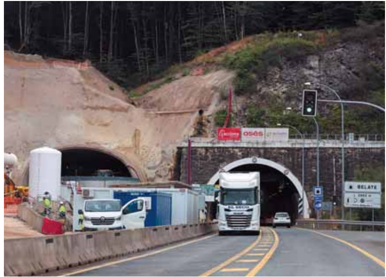
Imagen de los túneles de Belate y las obras que se llevan a cabo para su duplicación.
