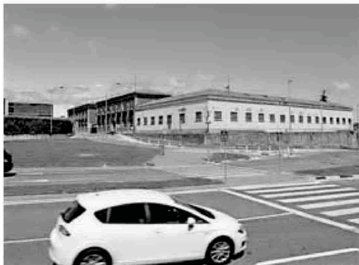
En los terrenos de la sede de Policía Foral se prevén 200 viviendas. GOÑI
