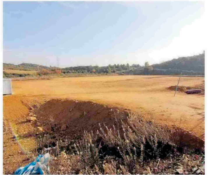
Terrenos donde se ubicarán los 60.000 m 2 del polígono industrial de Oncinada.
