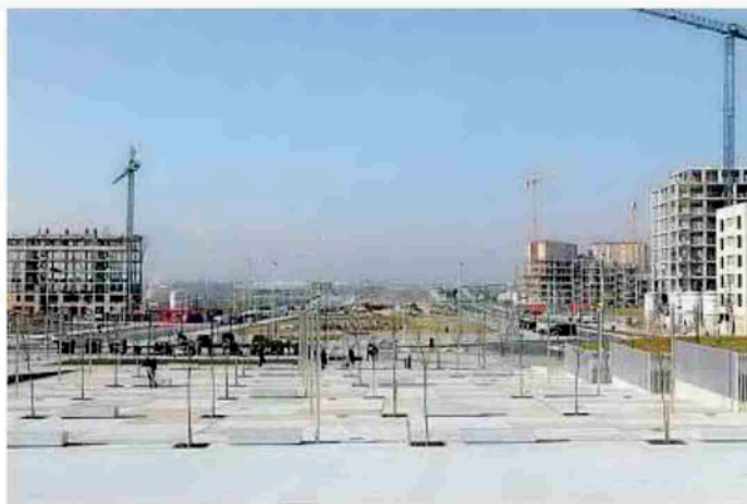
Viviendas en construcción en Arrosadía. Foto: cedida
