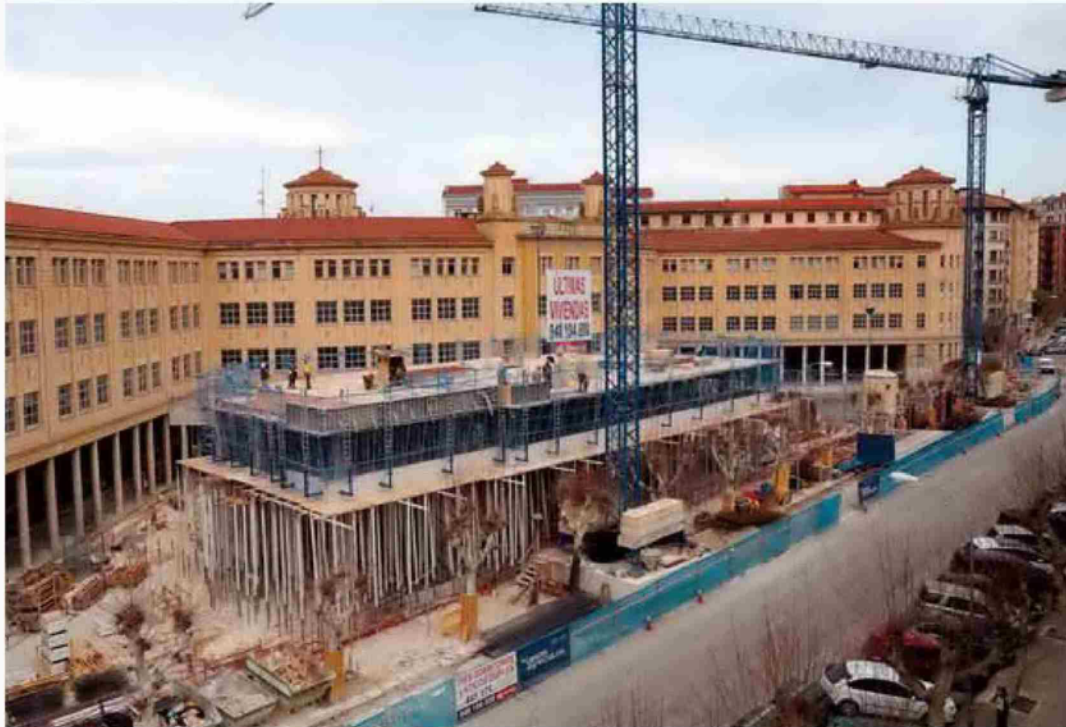
Imagen de las obras de construcción de viviendas junto a Maristas, tomada desde la Clínica San Fermín de la avenida Galicia.
