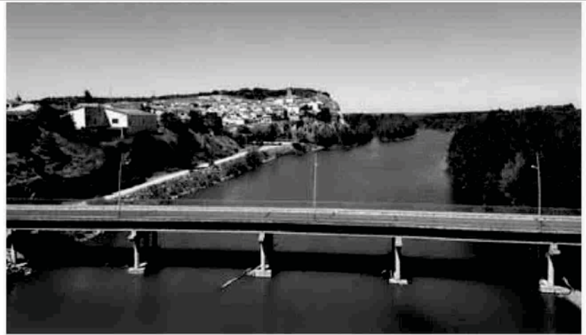
Vista general de Milagro con el puente sobre el río Aragón en primer término.
