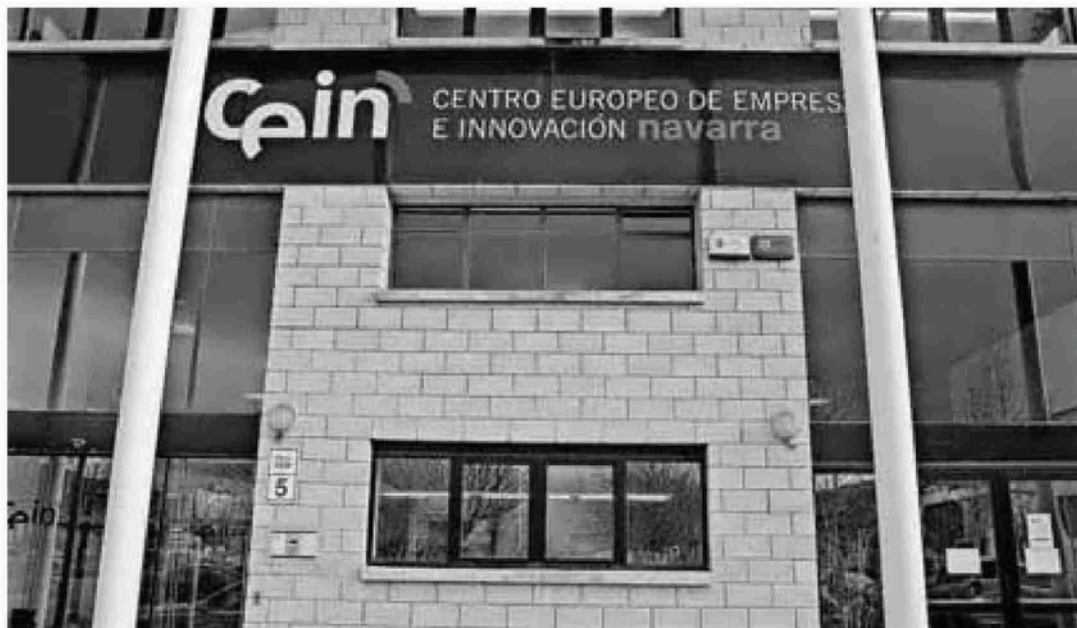
Fachada de las instalaciones de CEIN en el polígono Mocholf de Noáin.
