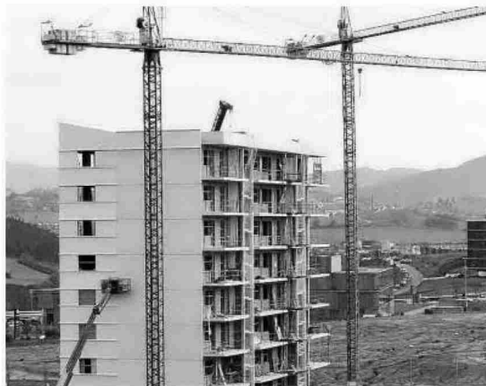
Edificio de viviendas en construcción. Foto: Javier Bergasa
