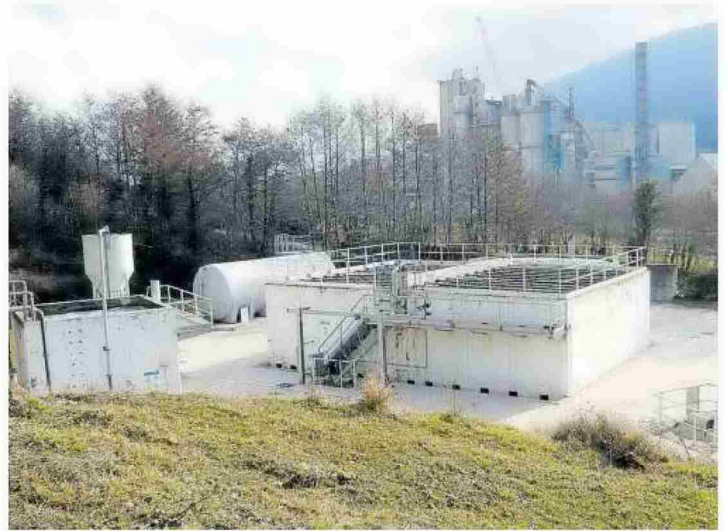
Imagen de archivo de la depuradora de Olazti, en marcha desde 1992. Foto: cedida
