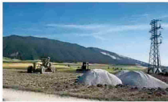
Vista del inicio de las obras en la cuarta fase de la CTP. ARCHIVO J.A. GOÑI
