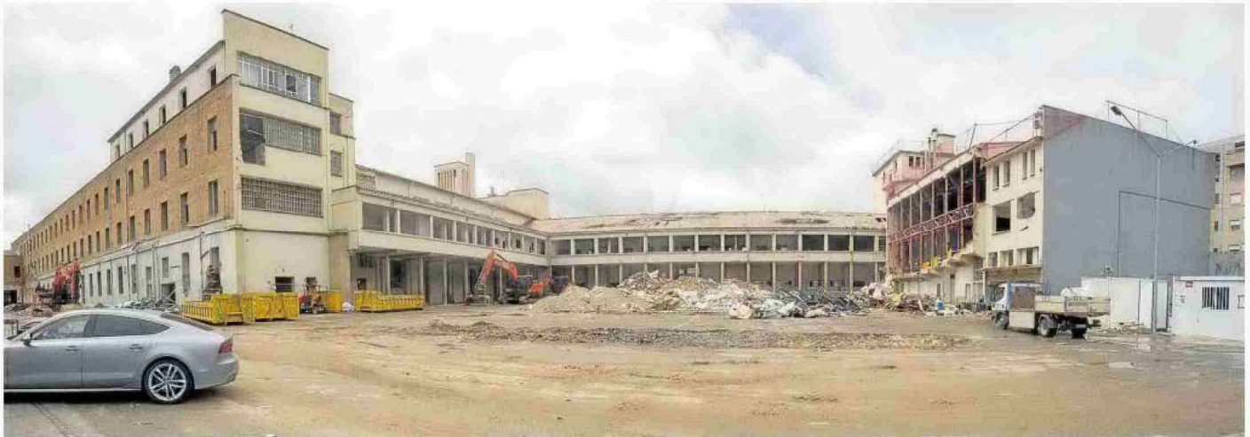
Imagen del solar despejado y el patio a la vista en la calle Media Luna tras los primeros derribos.
