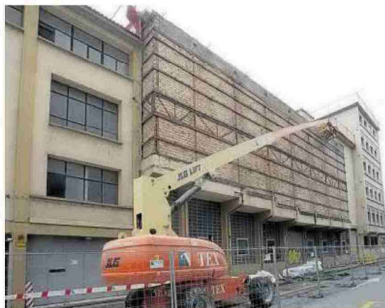
Una de las grúas trabajando en la calle Leyre.
