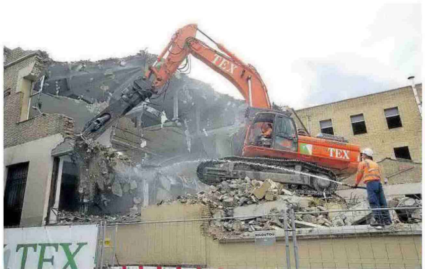
La retroexcavadora va subiendo por la rampa de escombros para arañar las cotas más altas.
