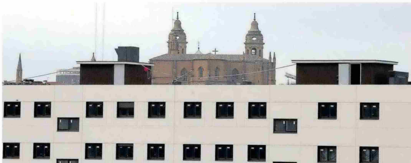
Imagen de viviendas en construcción en Txantrea Sur con la imagen de la Catedral al fondo. Foto: Javier Bergasa
