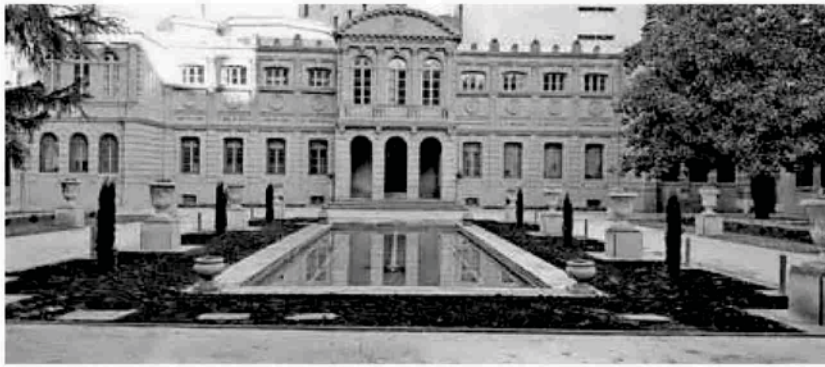
La remodelada entrada al antiguo Archivo de Navarra, tras las obras que se han realizado.
