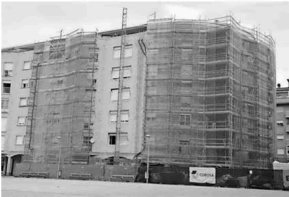
Imagen de las obras de uno de los bloques afectados de la plaza Ezcabazábal en Burlada.
