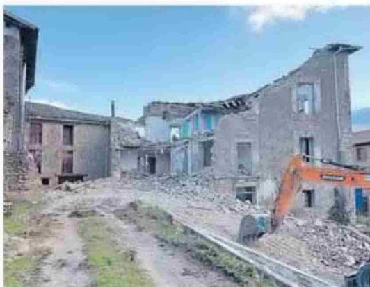
El derribo del antiguo hospital de Lumbier dará paso a VPO con Nasuvinsa.
