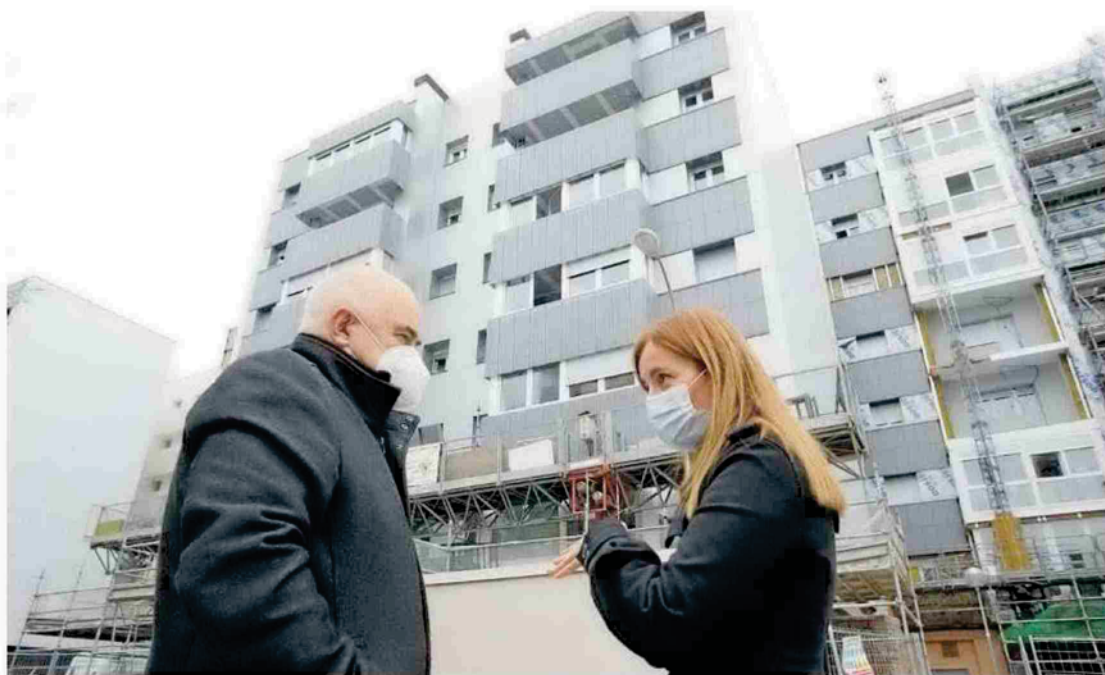
José María Aierdi, consejero de Vivienda, y Ana Bretaña, directora de Efidistrict, visitan unas las obras de rehabilitación en la Txantrea.
