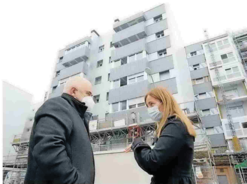
El consejero Aierdi y Ana Bretaña, directora de Efidistrict, en la visita a las obras de rehabilitación. Foto: cedida
