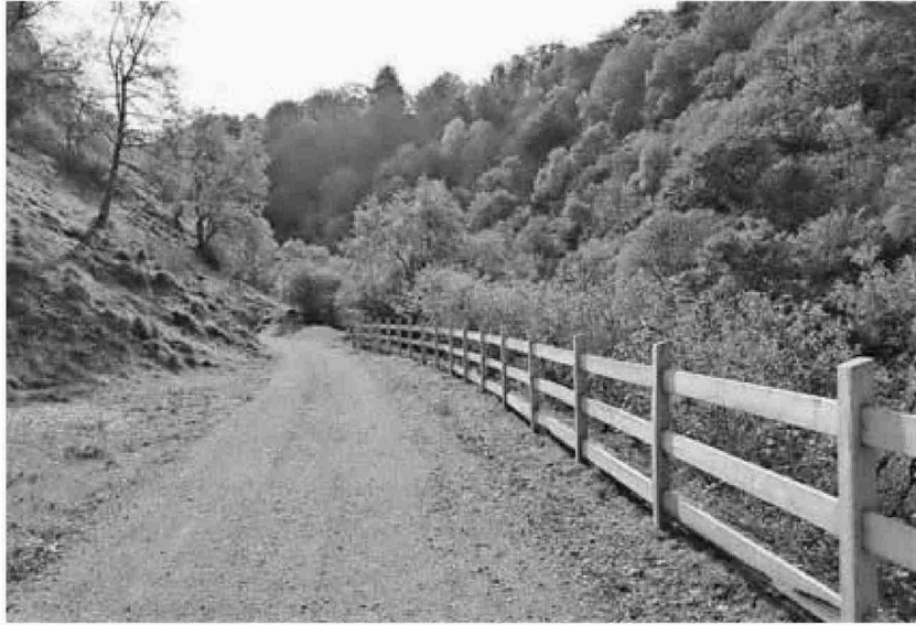
Detalle parcial del nuevo trazado, habilitado en Mugiro, como parte de la Vía Verde del Plazaola.
