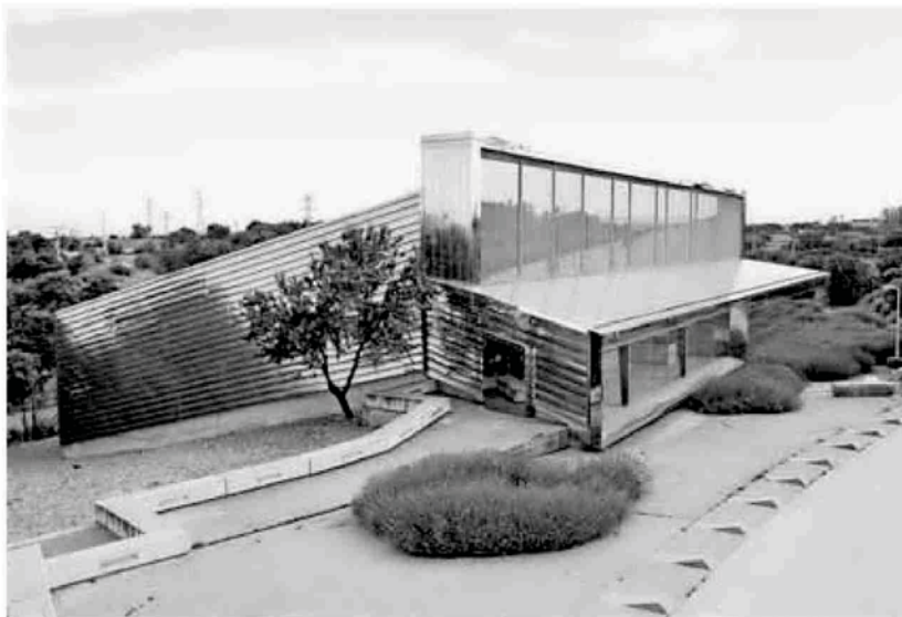
Una imagen del estado actual del tanque de tormentas de Tudela.
