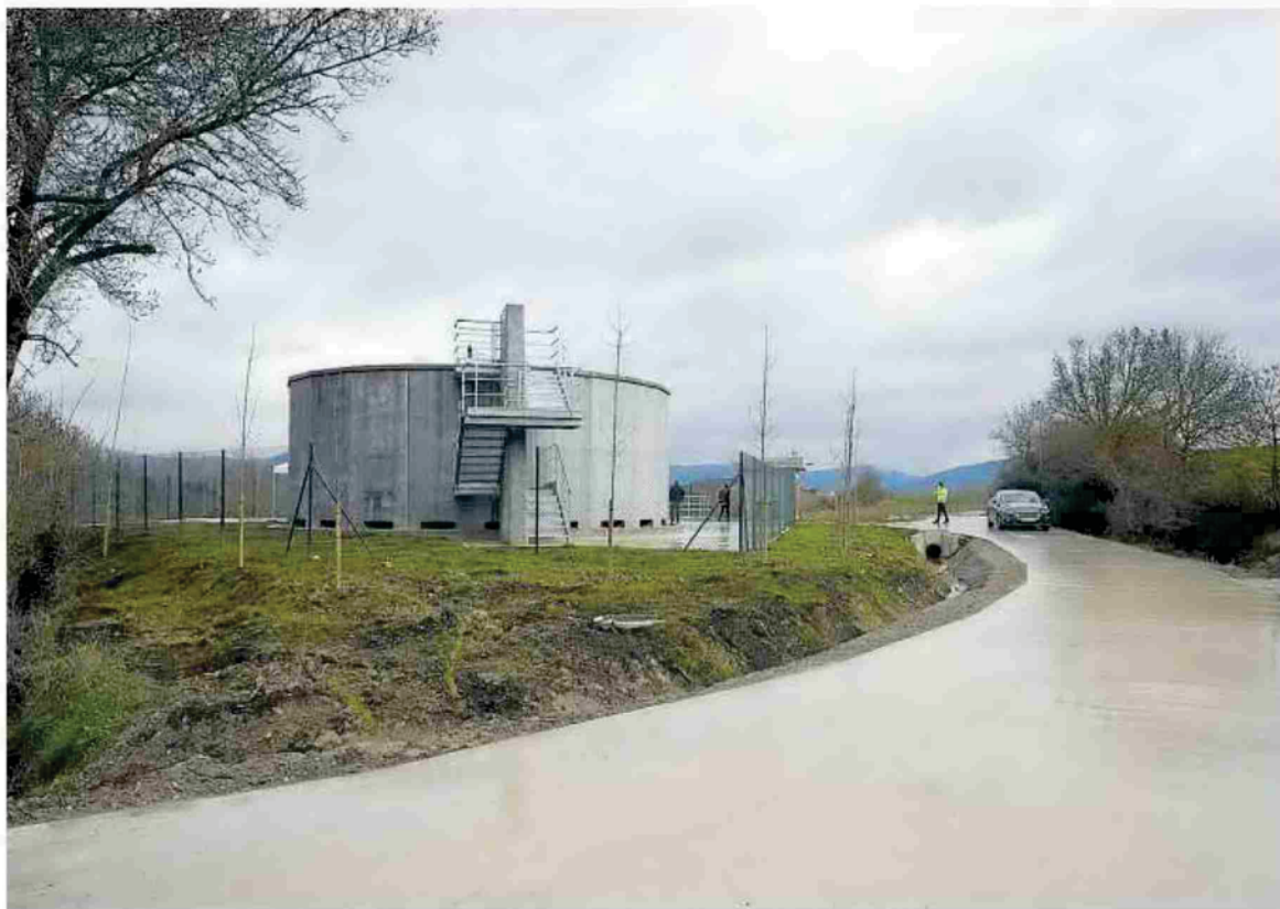
La nueva depuradora de aguas residuales, en la Cendea de Olza a 150 metros del núcleo urbano de Izu. Foto: Iñaki Porto
