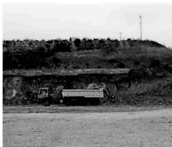
Siguen las labores de aplanamiento del solar.
