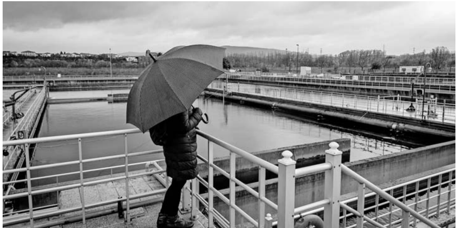
Una persona observa instalaciones de la estación depuradora de Arazuri.
