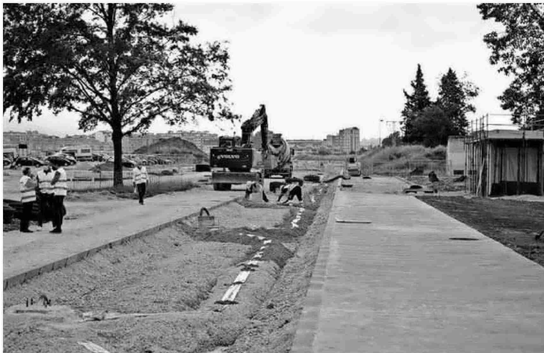
De derecha a izquierda, sección del nuevo vial de borde en Txantrea Sur: edificio de aseos construido en el futuro parque, acera peatonal, carril bici en obras que en su parte izquierda tendrá una franja de arbustos para separarlo de la calzada rodada, mediana con arbolado, calzada y futuras viviendas. Al fondo, viviendas de Burlada en la calle Bizkarmedia.
