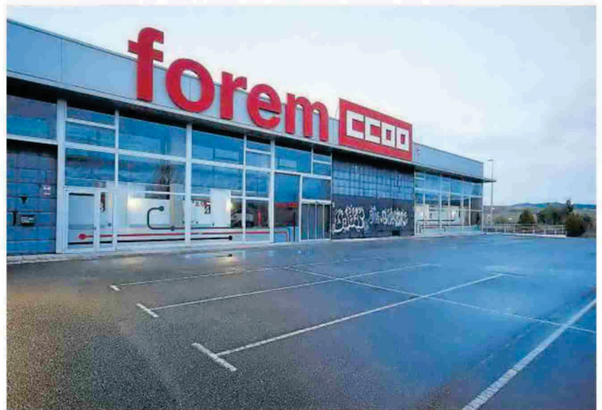
Exterior de las instalaciones de Forem, en Mutilva.
