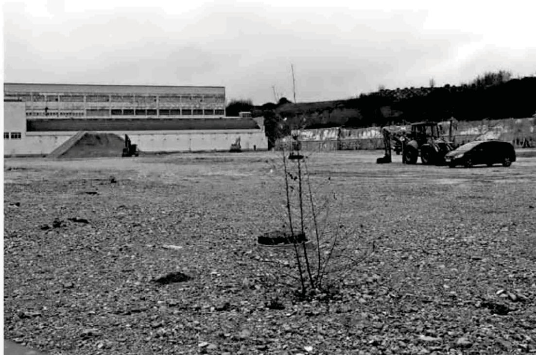
Estado actual de los terrenos de la antigua Super Ser, donde han continuado los trabajos para nivelar el suelo.
