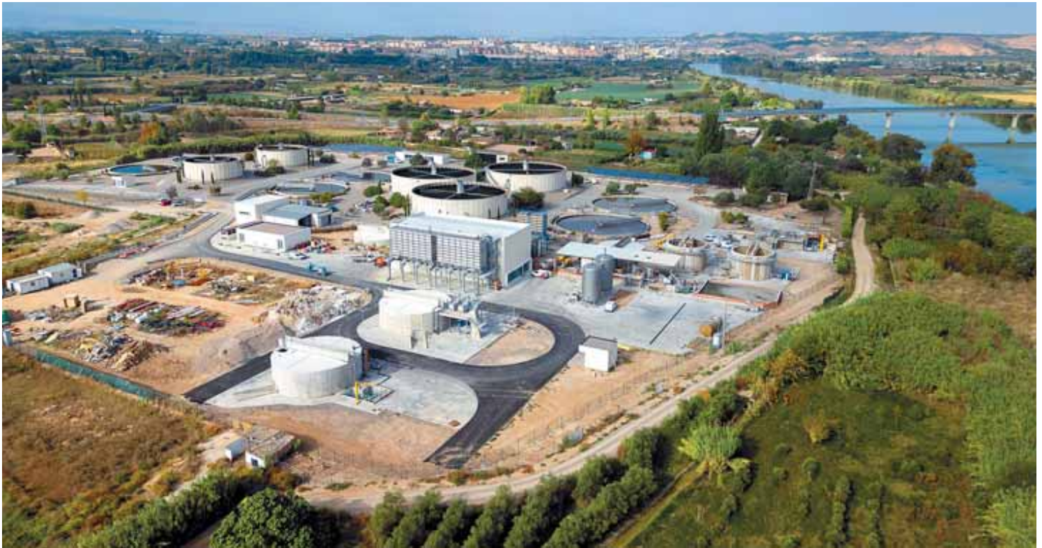
Imagen de la depuradora de aguas residuales de Tudela, con el casco urbano de la ciudad al fondo, y el cauce del río Ebro a la derecha.
