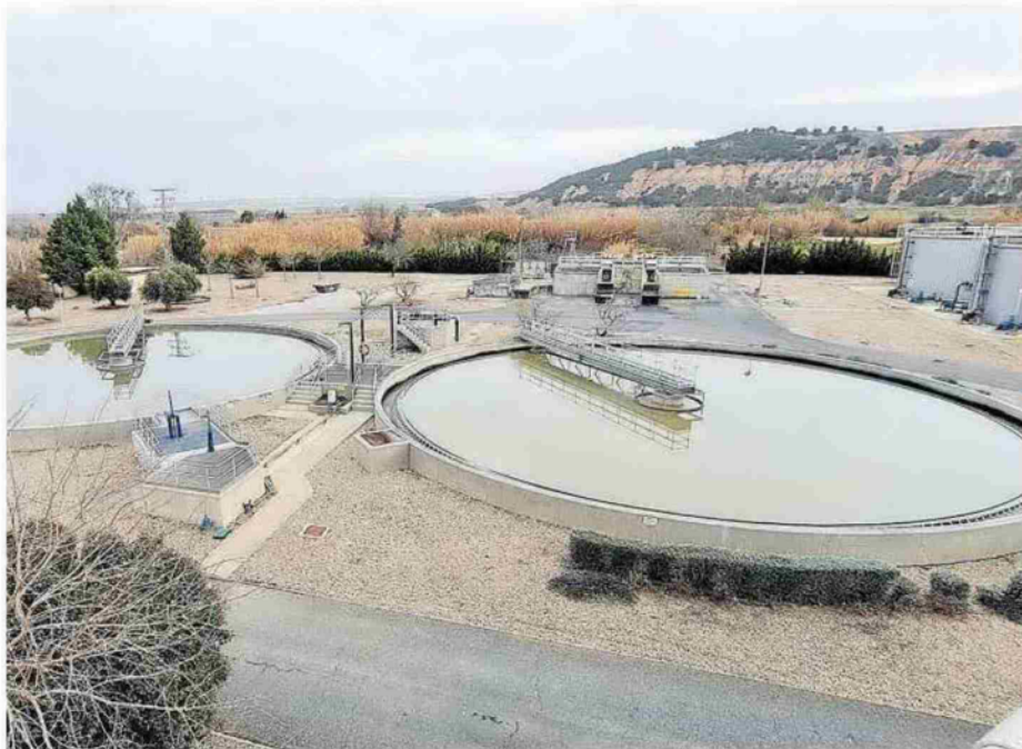
Vista panorámica de los depósitos de Tudela, donde se eliminan los sólidos que llegan con el agua de los colectores.
